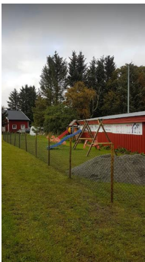
Ferdig oppsatt lekeplass med gjerde
