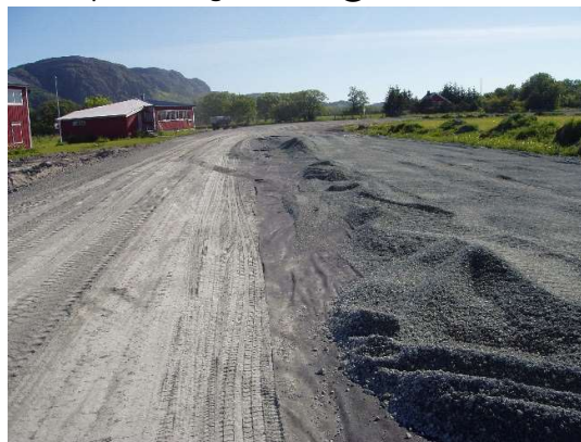
Her, noe av den nye bærelagsoppbyggingen.
