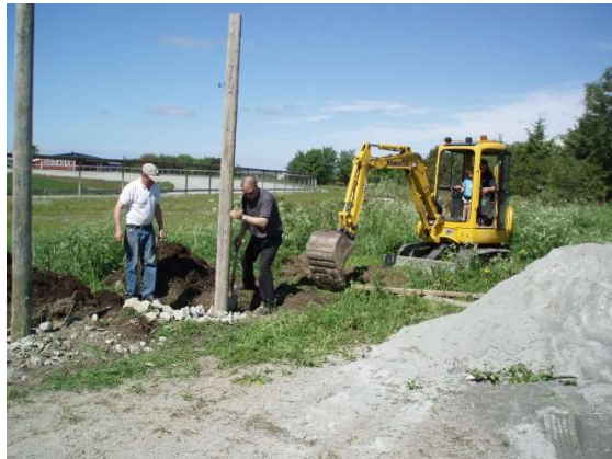
De første stolpene i bærekonstruksjonen plasseres.
