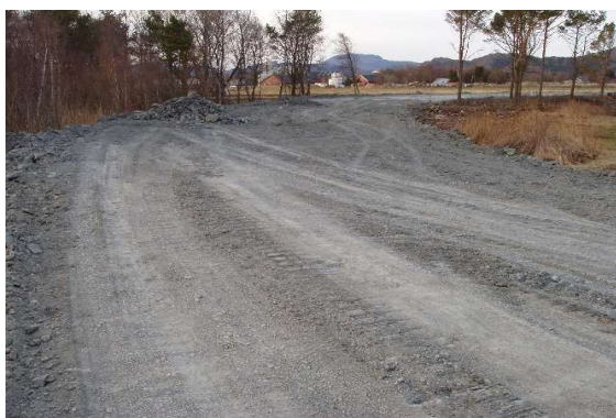
Baneprofil/bærelag er hovedsakelig ferdig formet av utgravingsmassene.
