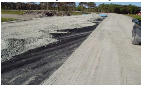
Langside forbi restauranten. Separert bærelag og drenslag under slitelaget.
