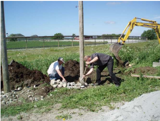
De første stolpene i bærekonstruksjonen plasseres.
