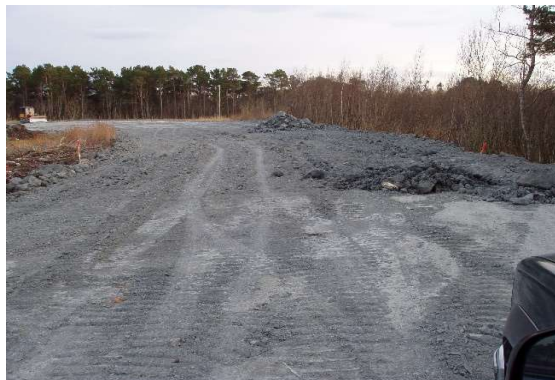
Baneprofil/bærelag er hovedsakelig ferdig formet av utgravingsmassene.
