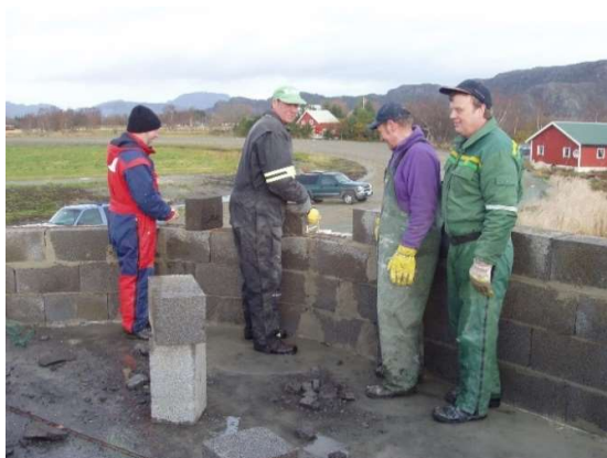
3. etg. Dette er hovedstammen i murerjengen.
